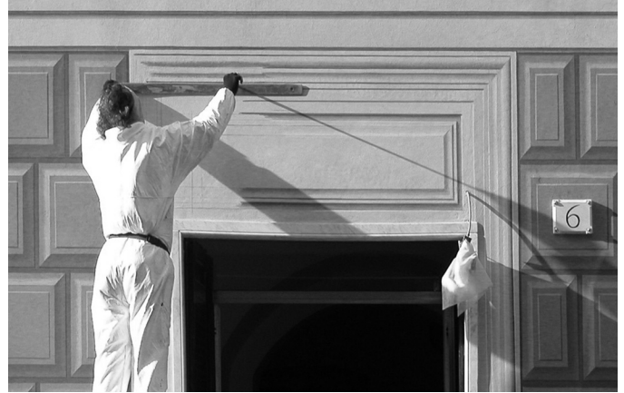
Fig. 8. Decoratore Massimo Pozzoni at work on Via Pertinace, 6.
